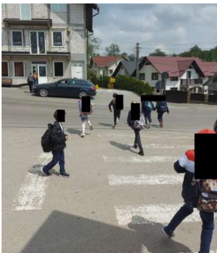
Figura 31 – Trece de pietoni cu marcaj necorespunzător (deteriorat)
