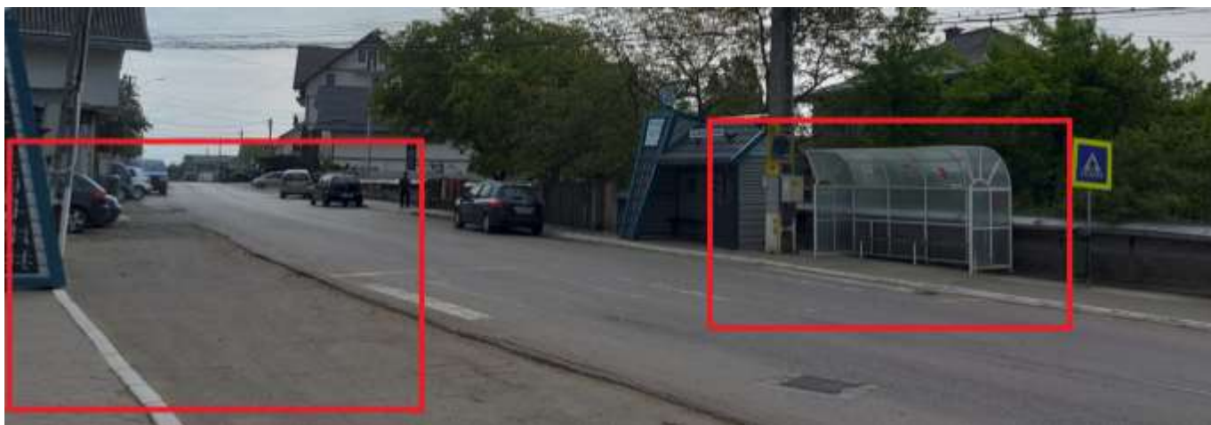
Figura 34 – Bordura din dreptul trecerii de pietoni nu este conformată pentru accesibilitatea persoanelor cu dizabilități locomotorii
