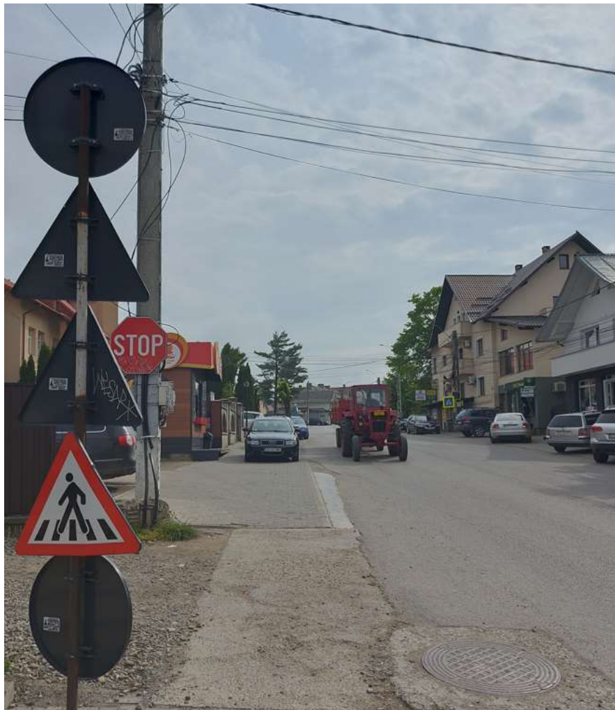
Figura 36 – Exemplu de amplasare necorespunzătoare a indicatoarelor multiple pe un stâlp
