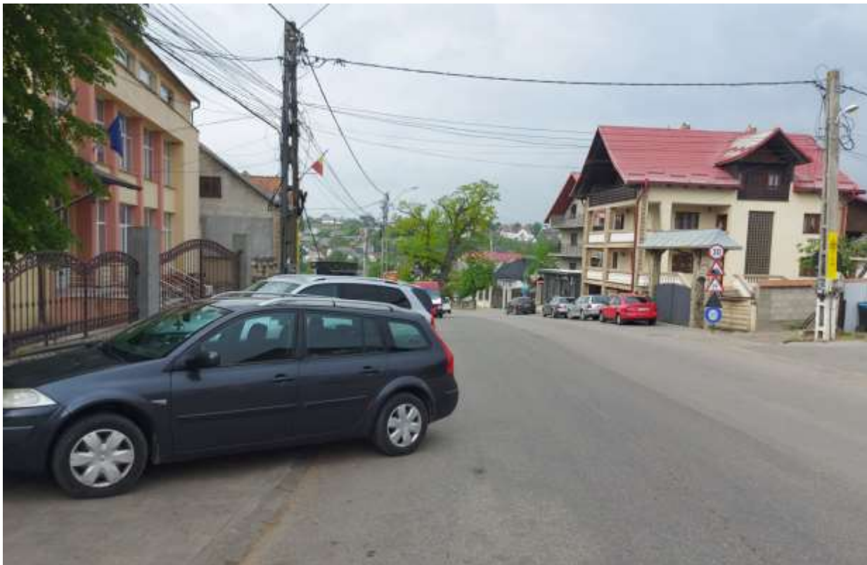
Figura 39 – Arteră rutieră principală fără marcaj longitudinal de separare a sensurilor
