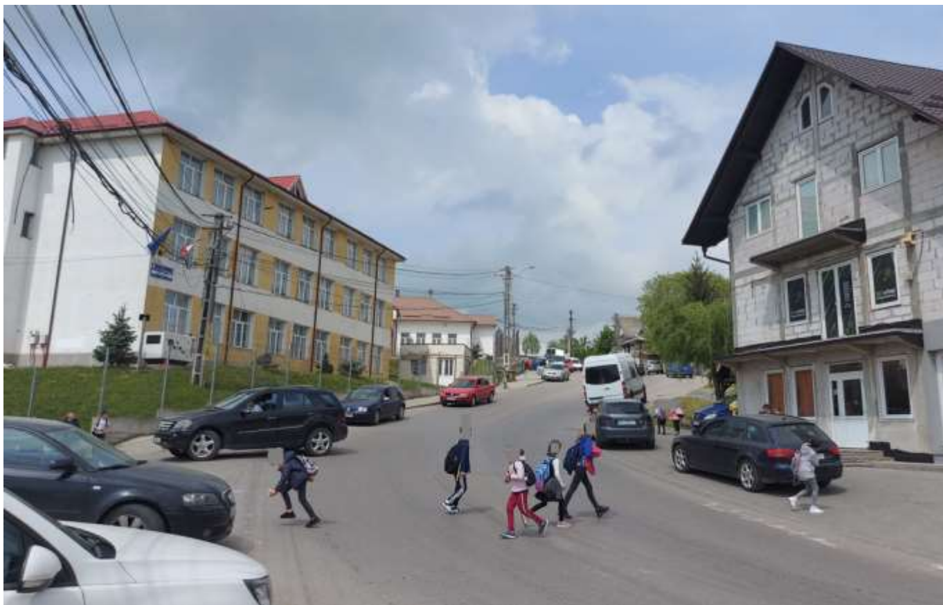
Figura 37 – Exemplu de marcaj de traversare pentru pietoni deteriorat (și greu vizibil)
